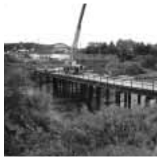
順調に進められている橋梁工事(下田平)
