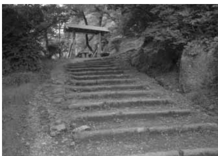
改修が行われる公園入口
