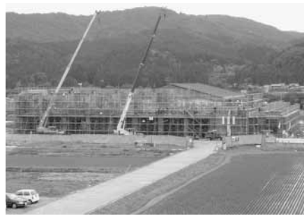
順調に進む総合体育館建設
