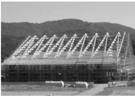
順調に建設が進む総合体育館
