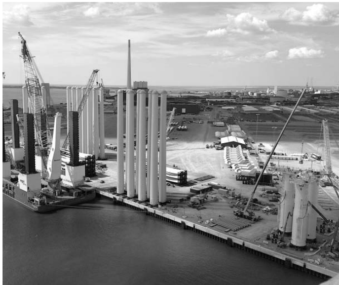
エスピアウ港での作業風景 (MH I ヴェスタス社提供)
