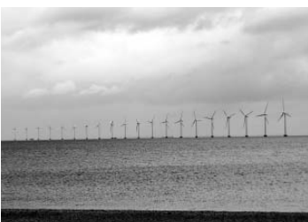
離岸距離約3キロ。2MW×20基のミドルグルンデン洋上風力発電所
