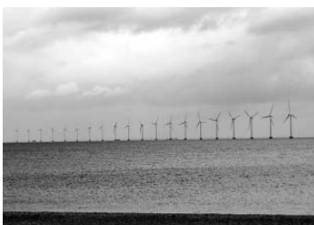
離岸距離約3キロ。2MW×20基のミドルグルンデン洋上風力発電所
