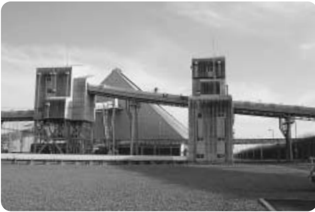
輸入された石炭はベルトコンベアで貯炭施設へ
