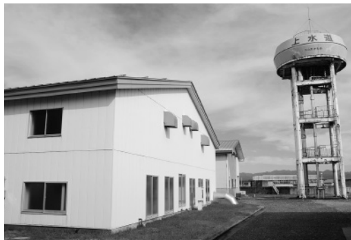
能代市仁井田浄水場
