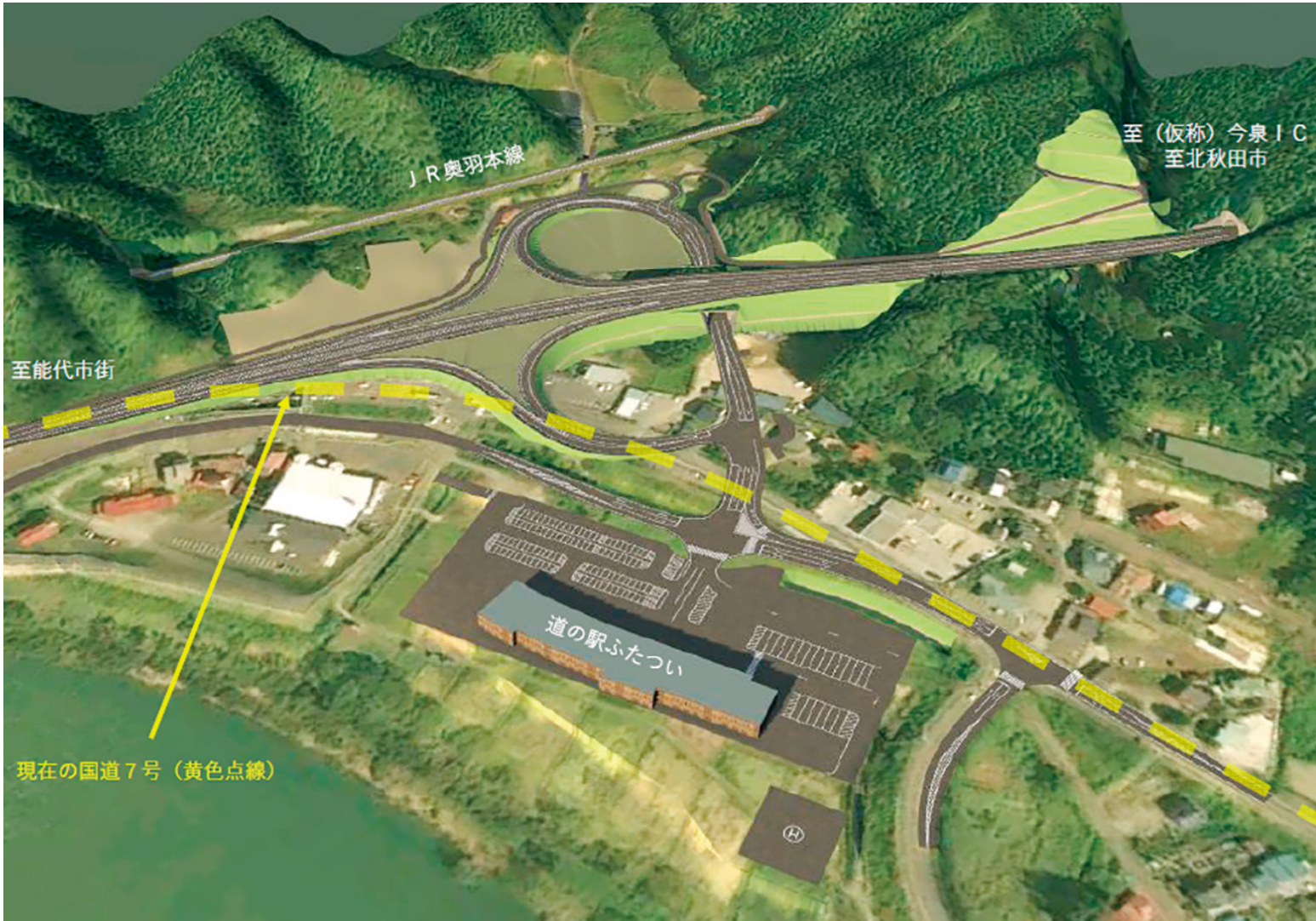
インターチェンジ完成後の道の駅ふたつ周辺 (提供：国土交通省 能代河川国道事務所)
