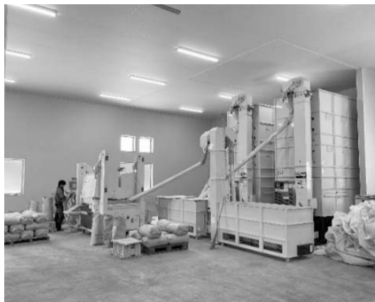
のしろ南大豆センター内の乾燥機と選別機
