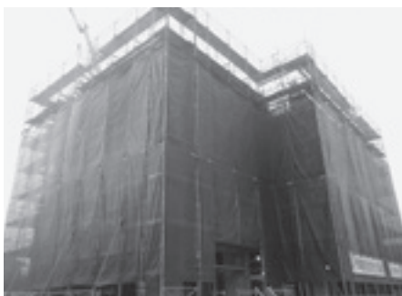
建設中の市営万町住宅
