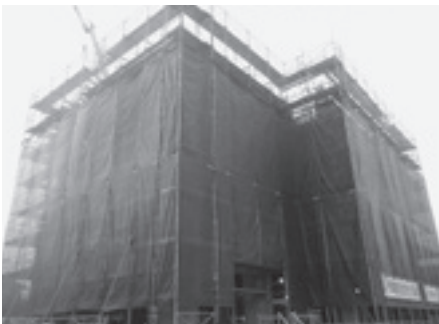
建設中の市営万町住宅
