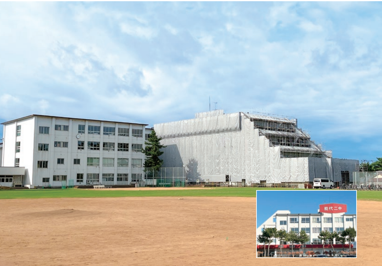
大規模改修が行われた能代第二中学校(中央：改修中、右下：改修後)
