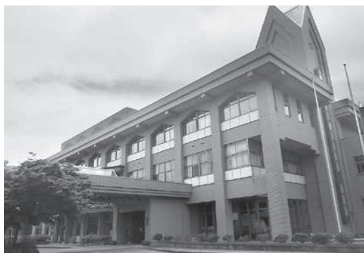
改修予定の二ツ井町庁舎
