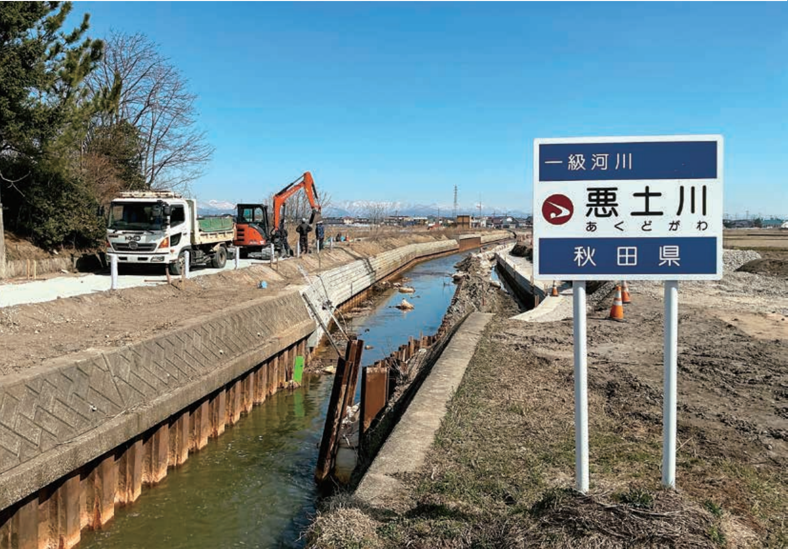
河川改修工事が進む悪土川
