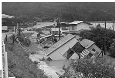
災害があった ニツ井町小繁地区 (きみまち阪付近)
