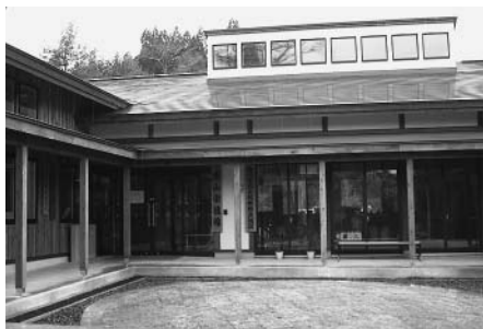
(能代市檜山地域拠点施設)
