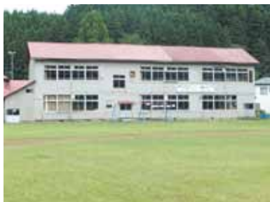
旧天神小学校の様子
