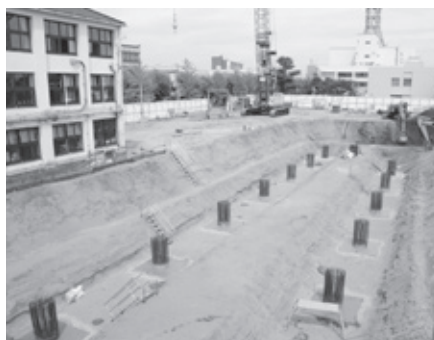
新庁舎の建設工事が行われています。
