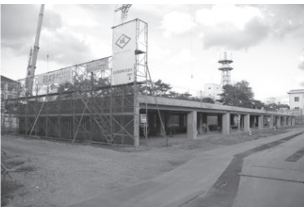
新庁舎建設工事(さくら庭)
