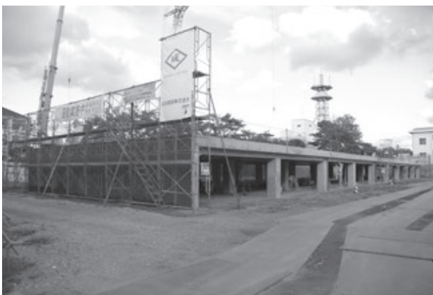
新庁舎建設工事 (さくら庭)
