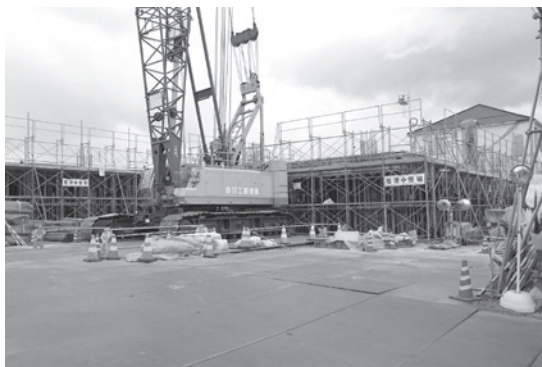
新庁舎建設工事（正面玄関）
