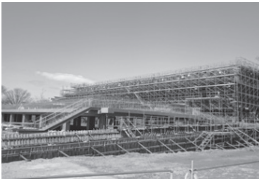
新庁舎建設工事(さくら庭)
