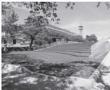
さくら庭駐車場の屋根部分へ通じる芝生の階段
