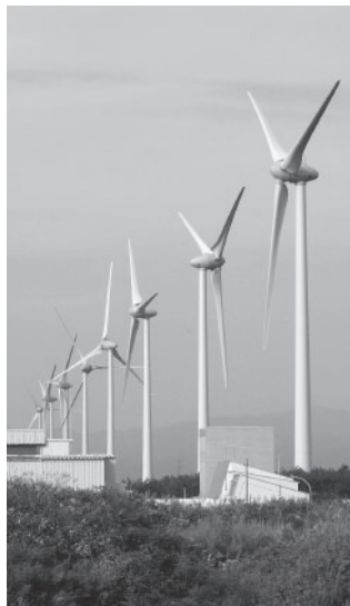
試験運転調整中の大型風車
