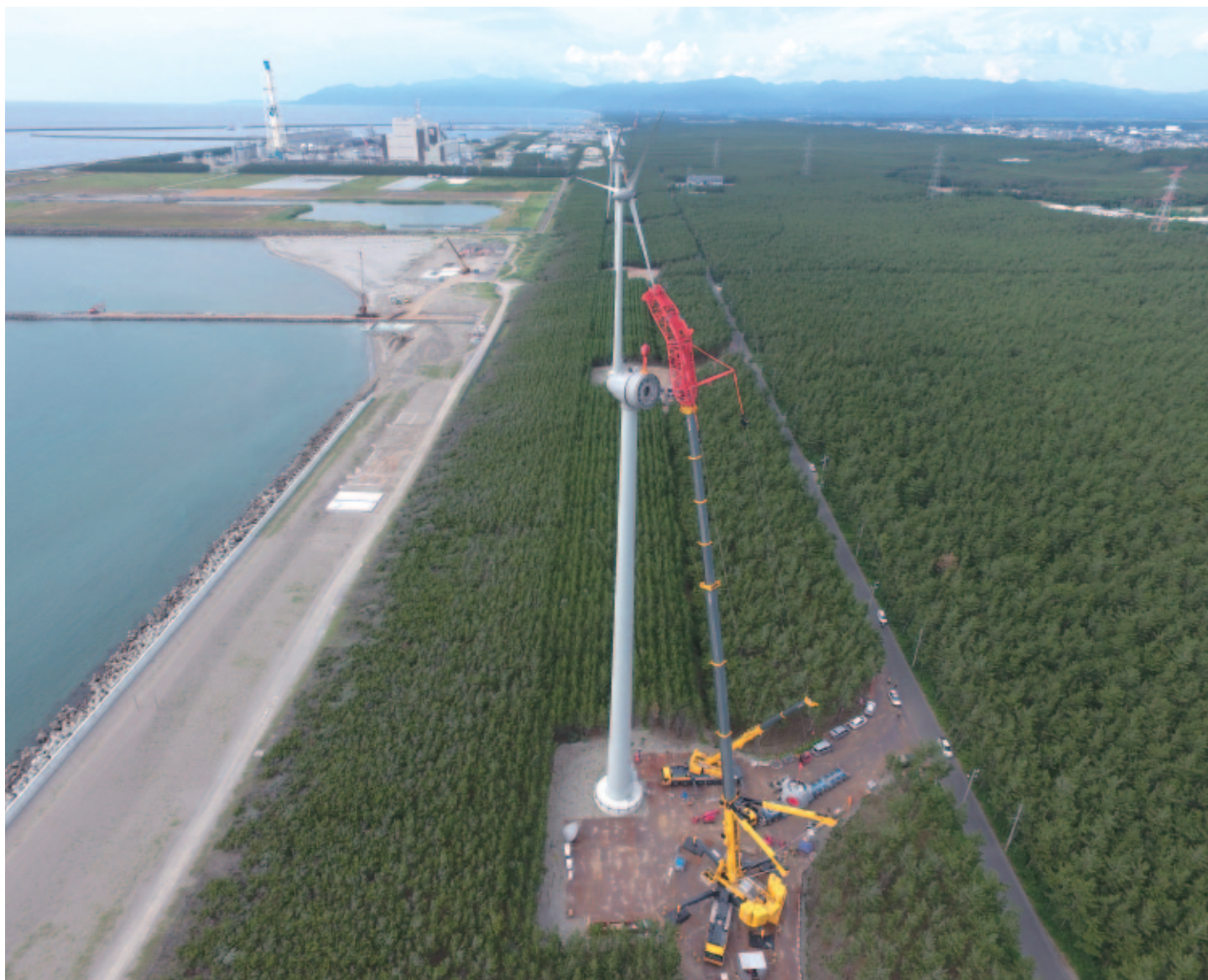
大型風車の組み立ての様子（7月25日空撮：左奥に能代火力発電所、奥に白神山地）
