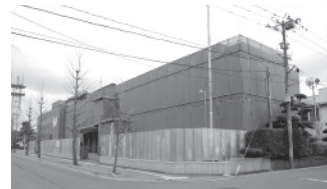
改修工事をしている第一庁舎
