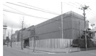
改修工事をしている第一庁舎
