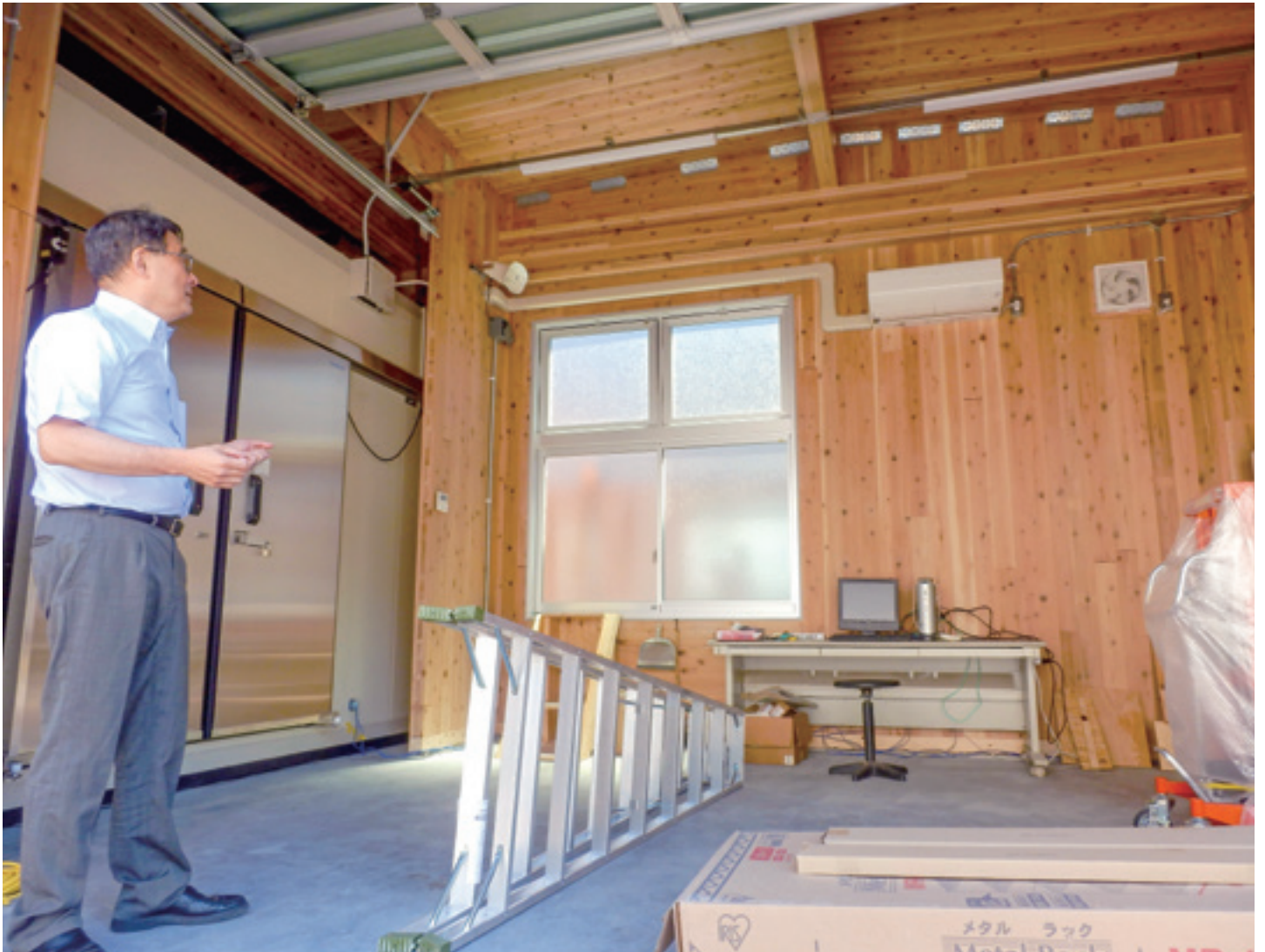
木材高度加工研究所が昨年度C L T (※)で建設した資材保管棟。左は木材高度加工研究所の林所長。 (※C L T =木の繊維の方向が直角に交わるように板材を重ねて接着した大型のパネル)
