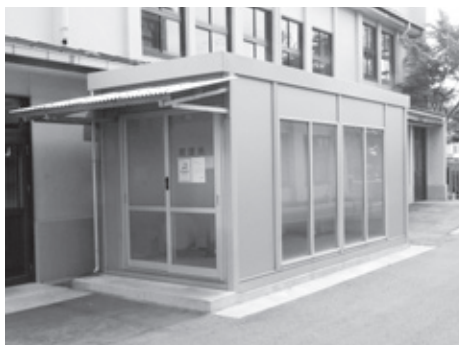
市役所本庁舎の屋外喫煙所
