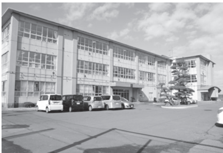
トイレ改修工事を予定している渟城南小学校
