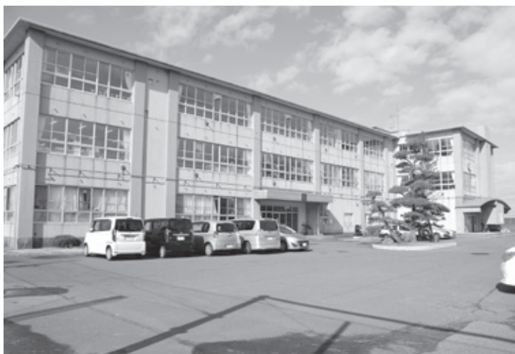
トイレ改修工事を予定している渟城南小学校
