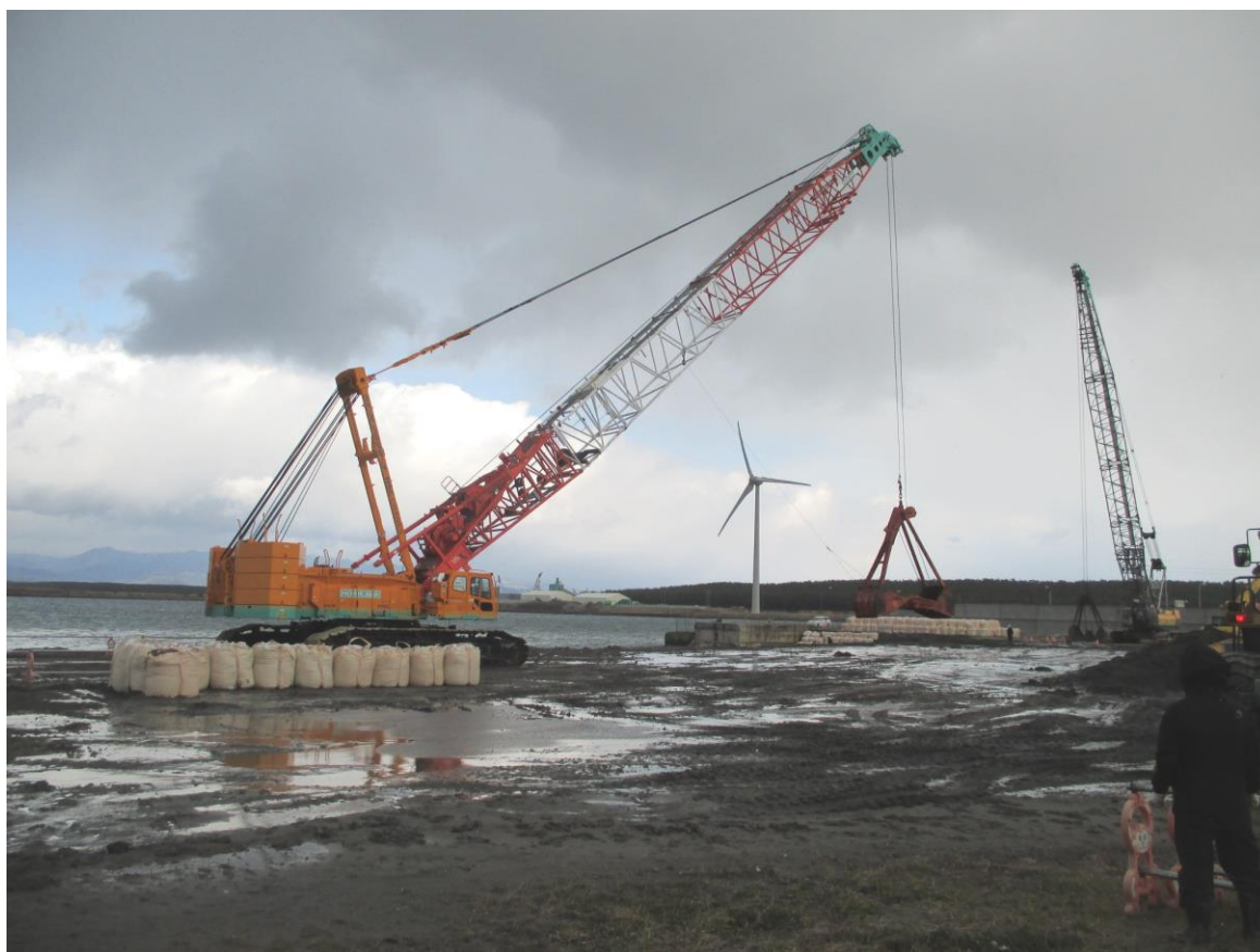
(能代港の港湾施設整備の様子)
