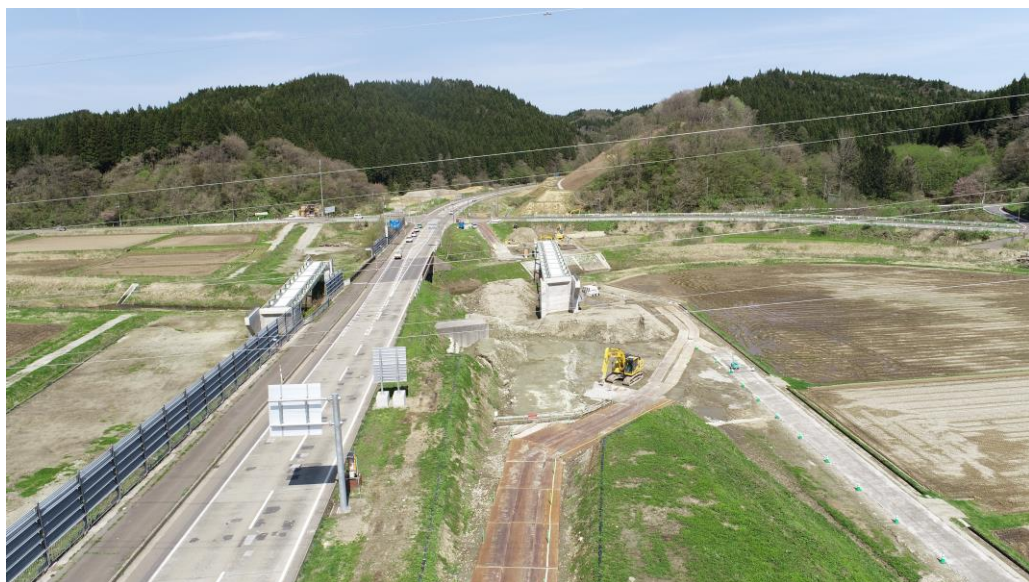
写真提供：国土交通省東北地方整備局能代河川国道事務所
