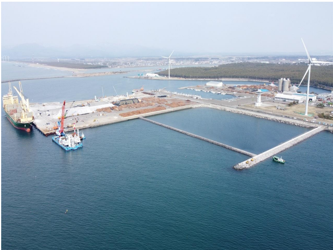
写真提供:秋田県能代港湾事務所
