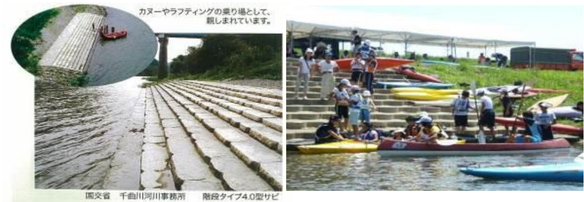
図 1-13 階段護岸を利用したカヌー発着場の写真
