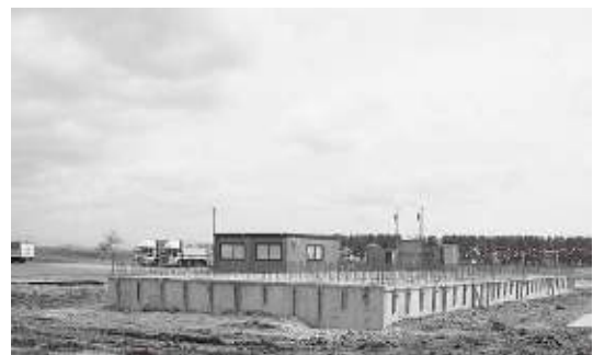
建設中の新規立地企業
