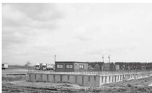
建設中の新規立地企業
