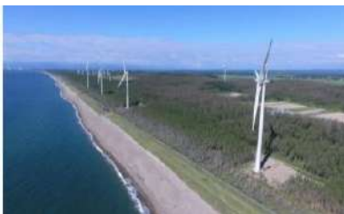
風の松原風力発電所
