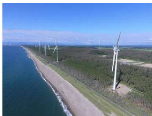
図 6-2 風の松原風力発電所
