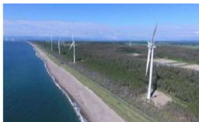
風の松原風力発電所
