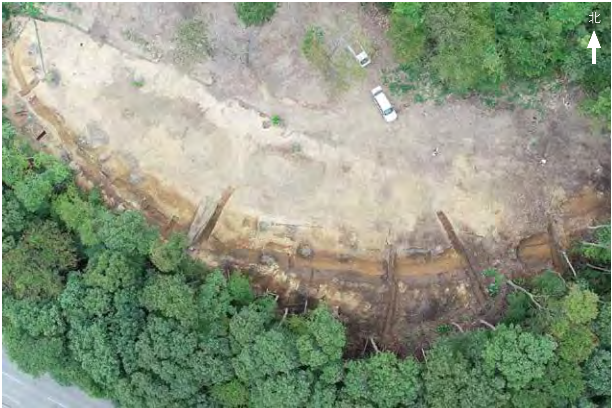
B区全景(SD41精査のため平場は排土置場に)
