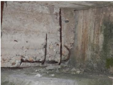
主桁の鉄筋露出
