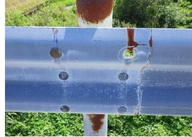
防護柵のボルトの脱落
