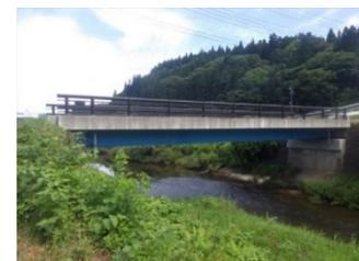
主要部材に鋼材(鉄)を用いた橋梁
