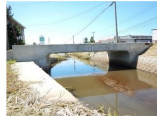
主要部材に鉄筋コンクリートを用いた箱型の橋梁
