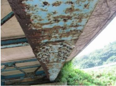
主桁の腐食
