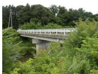
主要部材にプレストレストコンクリートを用いた橋梁
