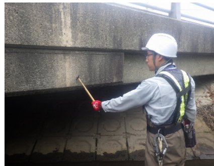
徒歩による点検状況
