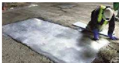
断面修復工（ゴムラテシリーズ）
