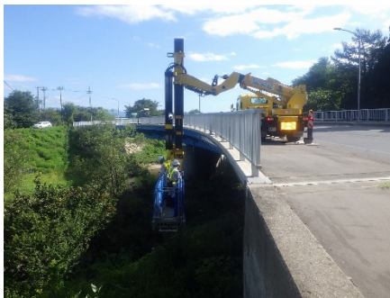
点検車による点検状況
