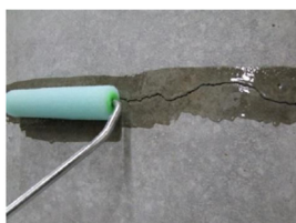
ひび割れ補修工（エポキシ樹脂塗布工法）
