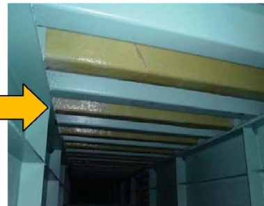
補修例：当て板補強工
