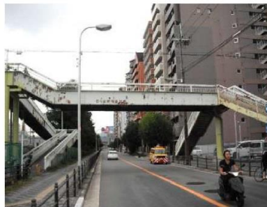
補修例：補修塗装工
