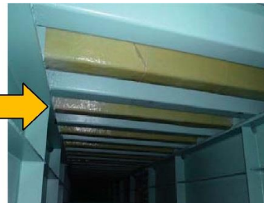
補修例：当て板補強工
