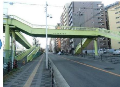
補修例：補修塗装工
