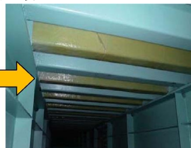
補修例：当て板補強工
