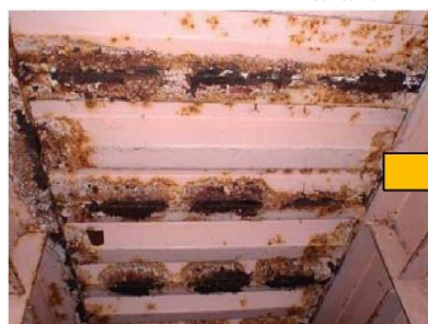
補修例：当て板補強工
