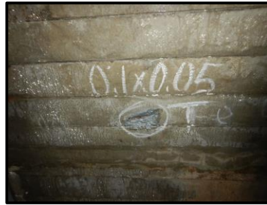
鋼材腐食 (防錆処置済)
