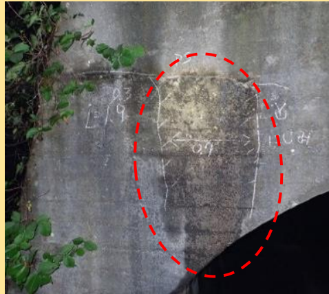
③わずかな水の染み出し。監視する。
