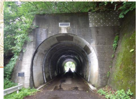
二ツ井側 トンネル入口
