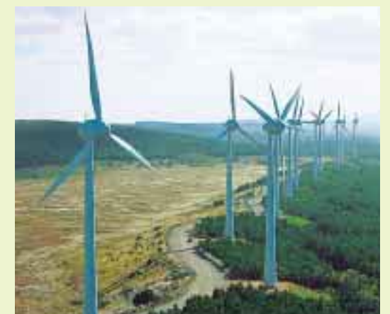
発電機がならぶ風力発電所
