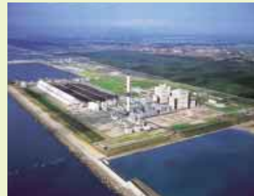
海の方から見た火力発電所
