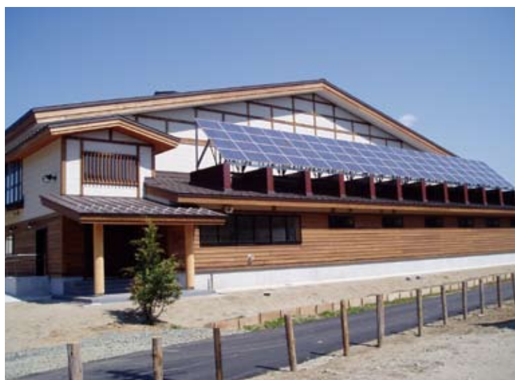
常盤小・中学校のソーラーシステム
