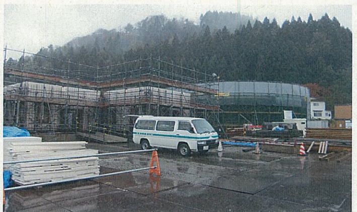
建設中の沢口浄・配水場全景
