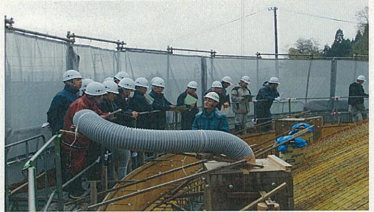
※配水池のドーム屋根から視察の様子
