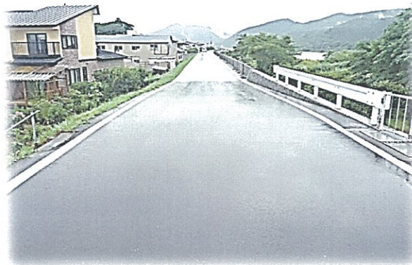
二ツ井堤防線（舗装）
