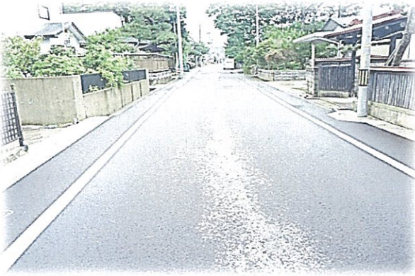
富根本線（側溝・舗装）
